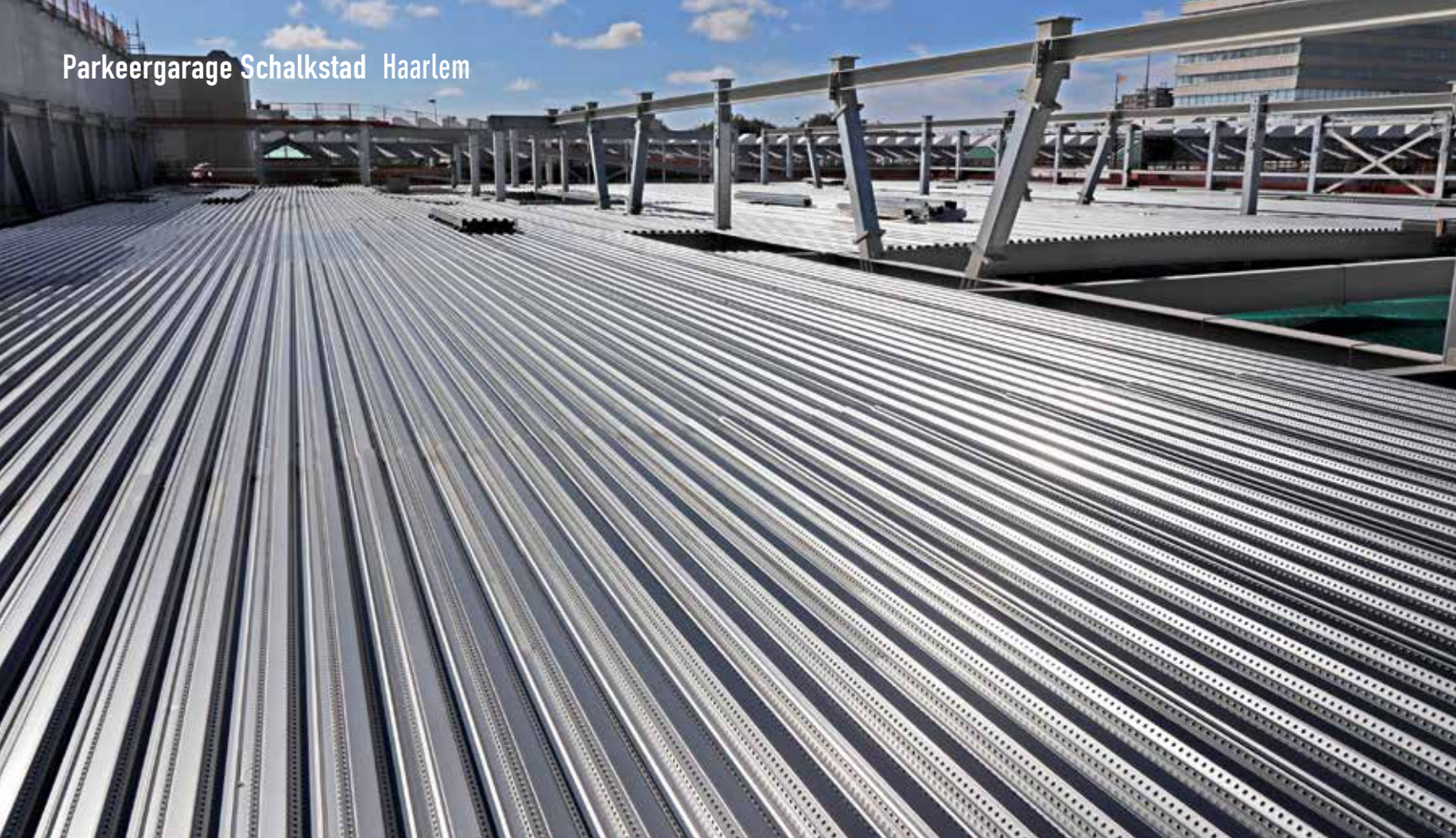
Verspreid over vier verdiepingen heeft Tullingham & Partners maar liefst 15.000 m 2 staalplaat-betonvloeren gemonteerd. Daarbij werd de voortgang van de staalconstructie gevolgd.
