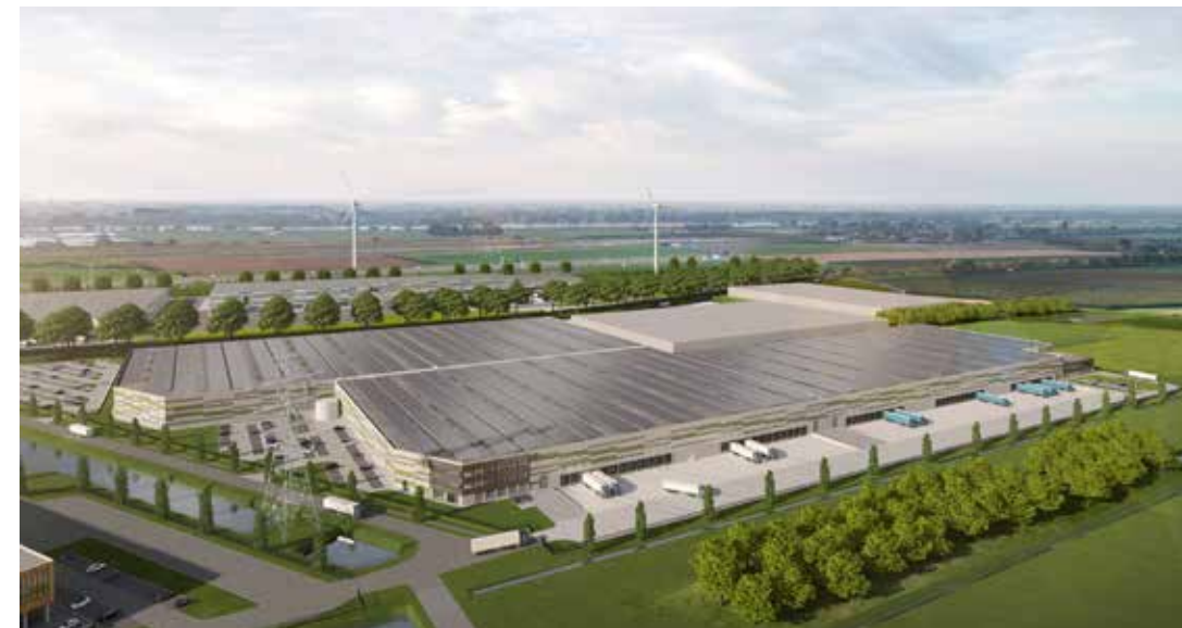
De daken van de geschakelde units worden ingevuld met PV-panelen.
